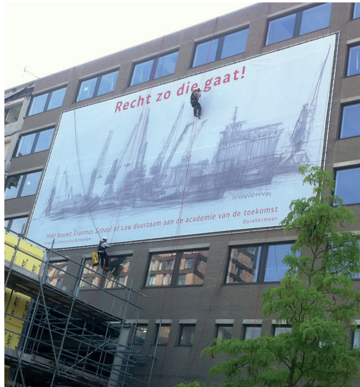
geveldoek aan de noordzijde
