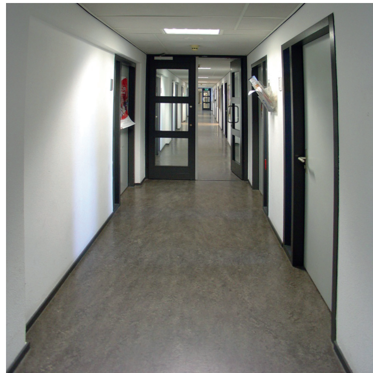
rechte lange gang L-gebouw vóór transformatie
